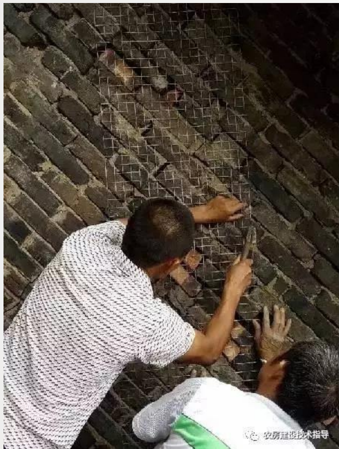
钢丝网水泥砂浆局部修补裂缝 (裂缝宽度2mm~5mm之间)
