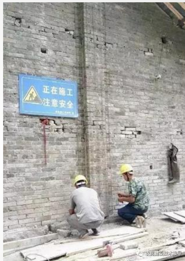
外包配筋细石混凝土加固山墙 高大扶壁柱
