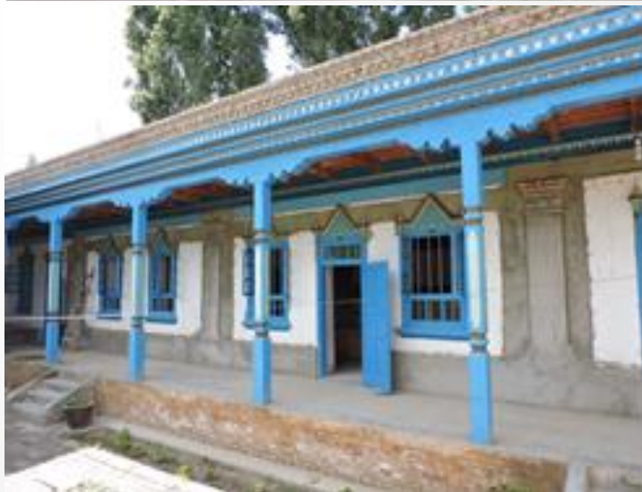
配筋砂浆带加固生土墙体 (新疆特克斯县木构架生土墙房屋加固)
