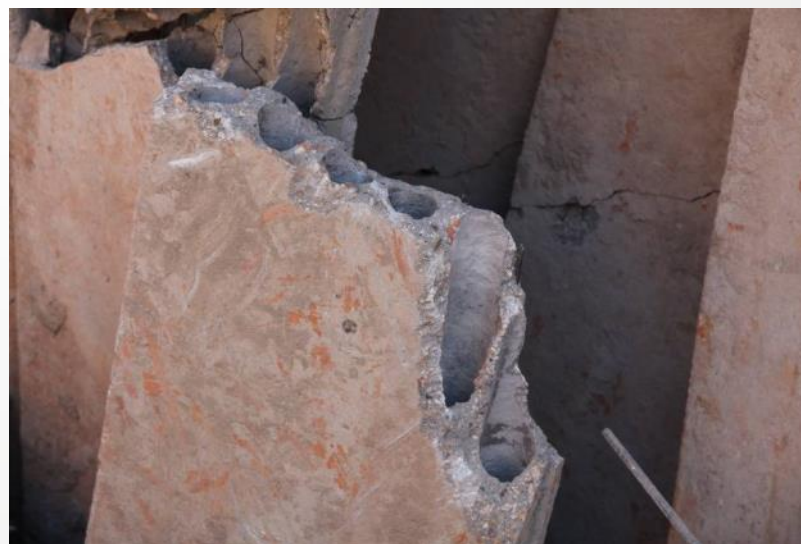
2011年陕西一处正在建造的农房，由于预制板质量不合格发生大范围断裂，房屋瞬间坍塌，造成7死1伤。
