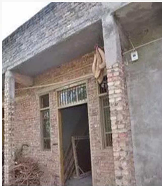
砖柱配筋包角增大截面加固 改善原砖柱强度不足和截面过小的问题
