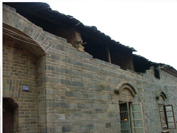
砖土混砌墙体的震害（九江地震）
