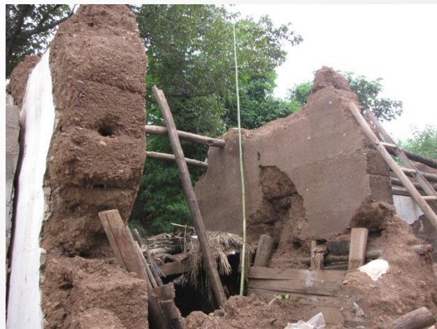
鲁甸地震生土墙承重房屋在地震中倒塌
