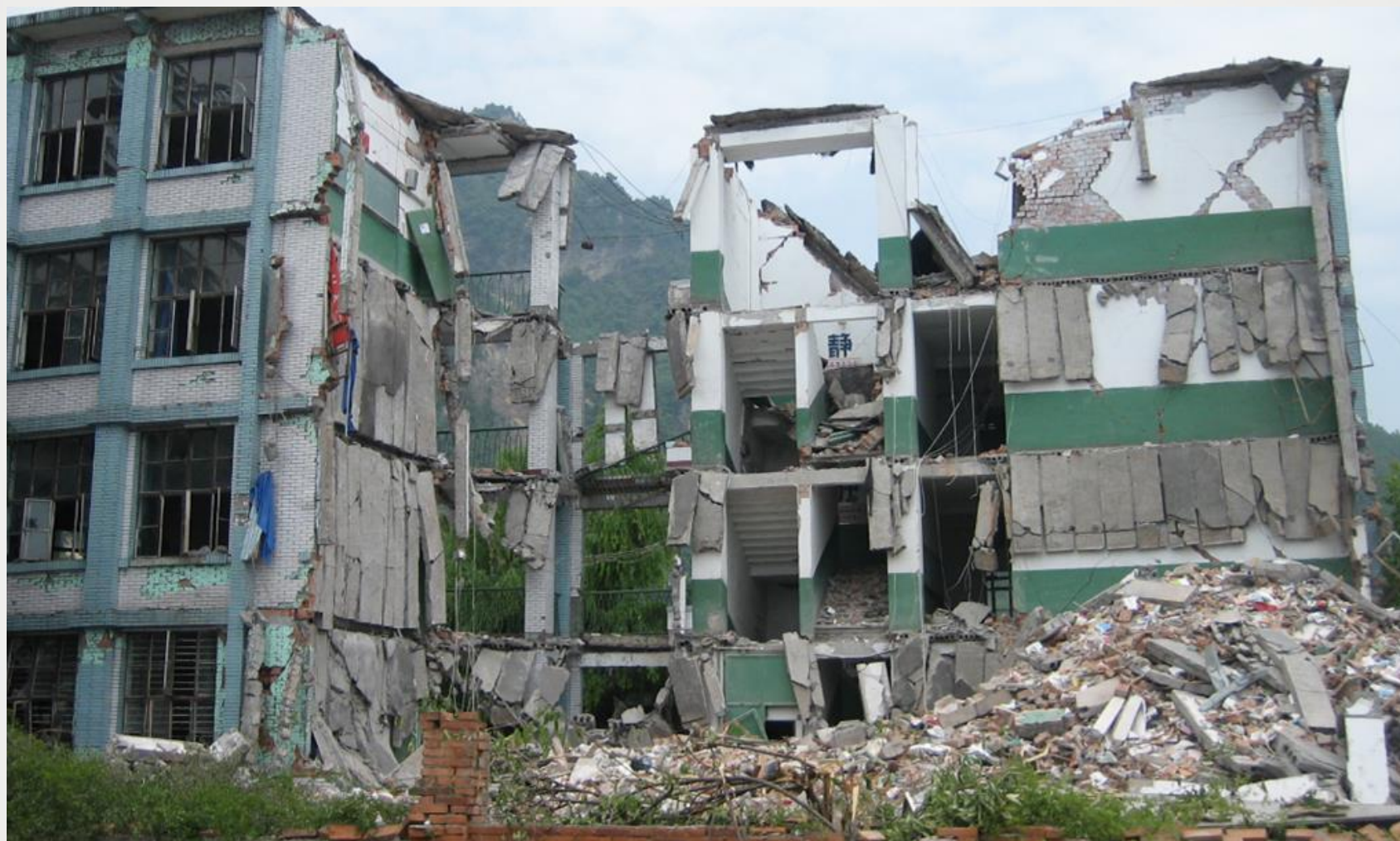
汶川地震中预应力圆孔板砌体结构教学楼的破坏 (无连接预应力圆孔板, 绵竹市汉旺中学)
