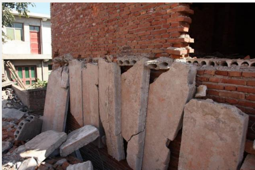
2011年陕西一处正在建造的农房，由于预制板质量不合格发生大范围断裂，房屋瞬间坍塌，造成7死1伤。
