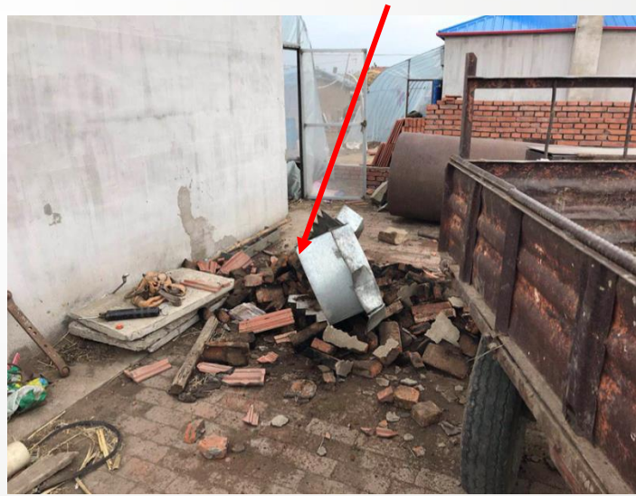
无拉结烟囱倒塌掉落
