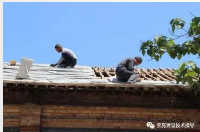
加固维修过程
