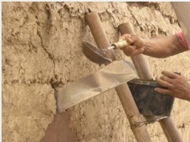
采用自制灌浆槽灌浆
