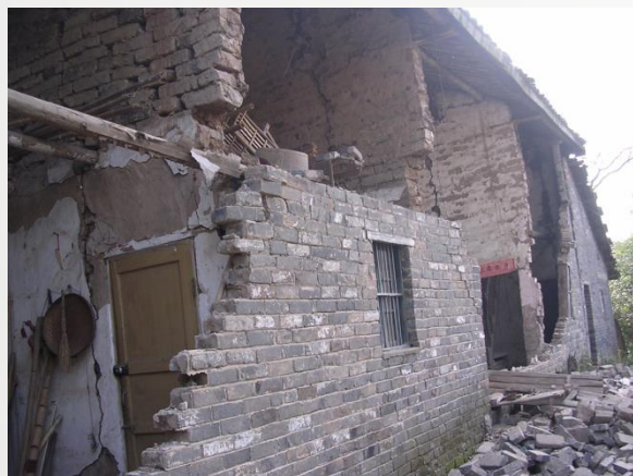
砖土混砌墙体的震害（九江地震）
