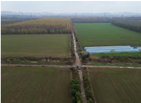
诗遥湾中心路项目起点
