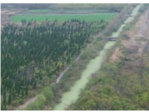
街道段标线缺失临水缺少防护设施
