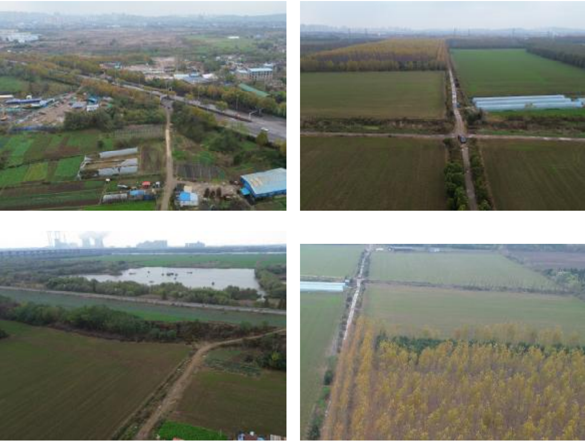
老路路基现状
